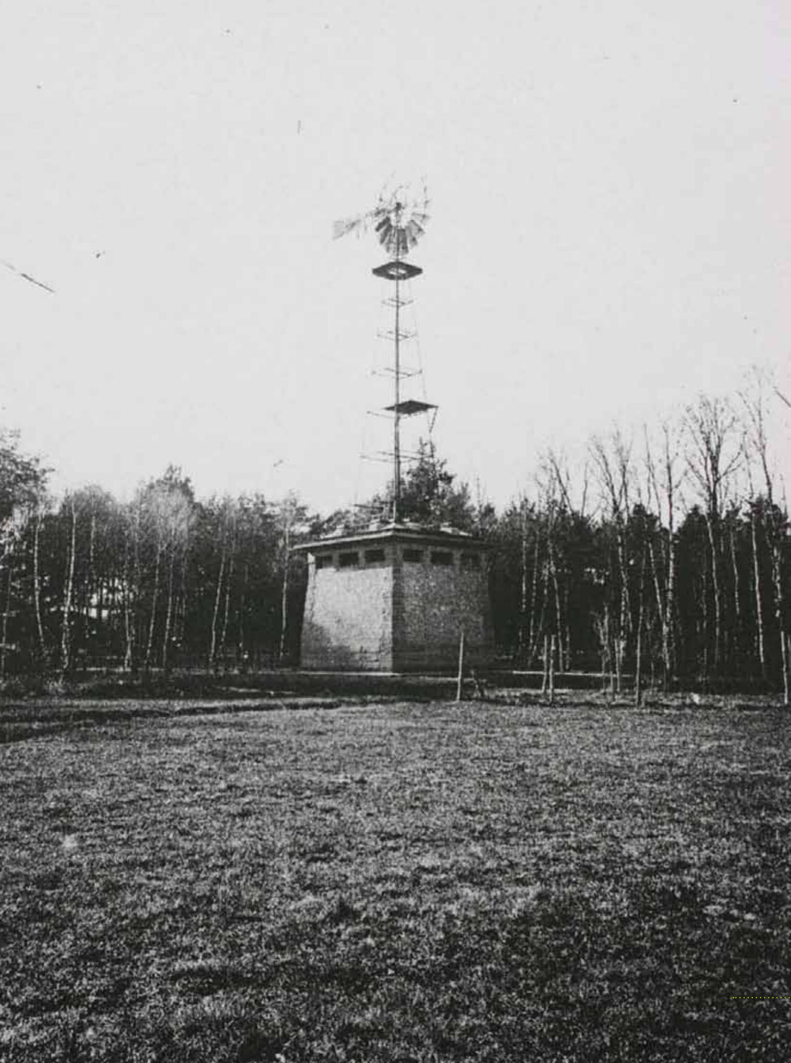
Pompgebouw met windmolen
